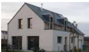
Maison labellisée BBC-Effinergie en Ille-et-Vilaine Source : ALEc
